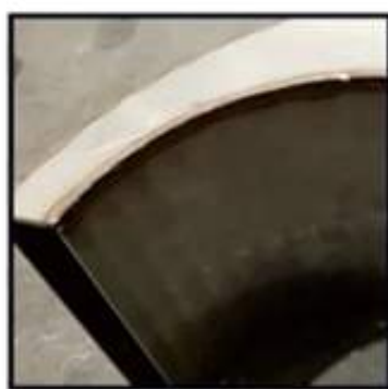
Soldadura de esquinas externas
