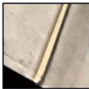
Soldadura a tope
