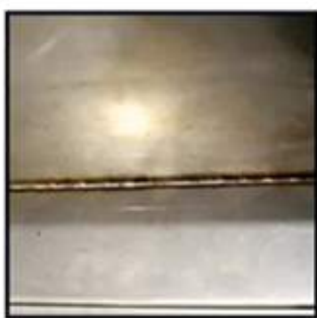
Soldadura interior de esquinas
